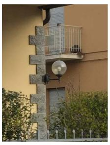
Le immagini sopra riportate evidenziano il frequente utilizzo di apparecchi illuminanti tipo Globo, che hanno evidentemente uno spettro di emissione omnidirezionale e quindi non conforme a quanto richiesto dalla Legge Regionale.
