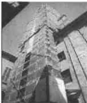
**DESCRIZIONE DELL'INTERVENTO:** INTERVENTO DI SUPERAMENTO DELLE BARRIERE ARCHITETTONICHE AI FINI DELLA VISIBILITÀ, CREAZIONE DEL MUSEO DELLA CATTEDRALE E RESTAURO CONSERVATIVO DELLA TORRE CAMPANARIA. REALIZZAZIONE DI STRUTTURE PER L'ACCESSO AI DISABILI, CONSOLIDAMENTO, RIFACIMENTO DI IMPIANTI (ELETTICO, TERMICO, IDRICO SANITARIO) E INTERVENTI INERENTI LA PREVENZIONE INCENDI.
