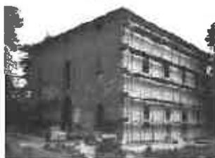
**DESCRIZIONE DELL'INTERVENTO** : RISTRUTTURAZIONE, RESTAURO, ED ADEGUAMENTO IN MATERIA DI IGIENE E SICUREZZA DEL LAVORO, PREVENZIONE INCENDI, IMPIANTI (ELETTRICO, TERMICO, ANTINCENDIO, IDRICO SANITARIO, CLIMATIZZAZIONE) E ACCESSIBILITÀ AI PORTATORI DI HANDICAP,
